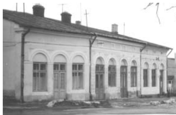
Fig. 96. Casa Hinek. Vedere de ansamblu, dinspre piață. Se remarcă denaturările introduse la parter și la ferestrele etajului
