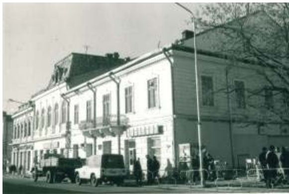
Fig. 116. Clădirea cu program mixt din Calea Națională nr. 275. Fațada laterală este încununată cu pinion
