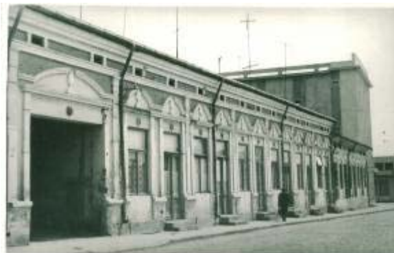
Fig. 101A. Clădirea din str. Miorița nr. 3 – 5 Vedere generală
