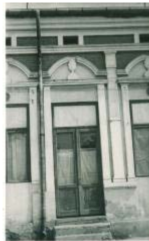
Fig. 101B. Clădirea din str. Miorița nr. 3 – 5. Detaliu de decorație cu elemente Empire
