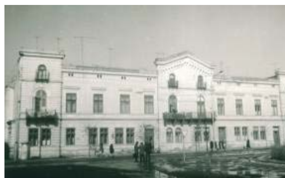
Fig. 106. Calea Națională nr. 225 – 231. “Casa morii”, han rezultat din reunirea a patru case vechi, fațadele fiind unificate cu arhitectură romantică (cca 1860). Dărâmat
